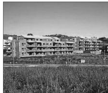
Viviendas inacabadas en Málaga.
