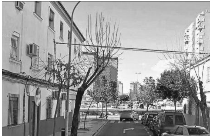
Fachada de un edificio a rehabilitar en la calle Virgen del Rocío. L. O.
