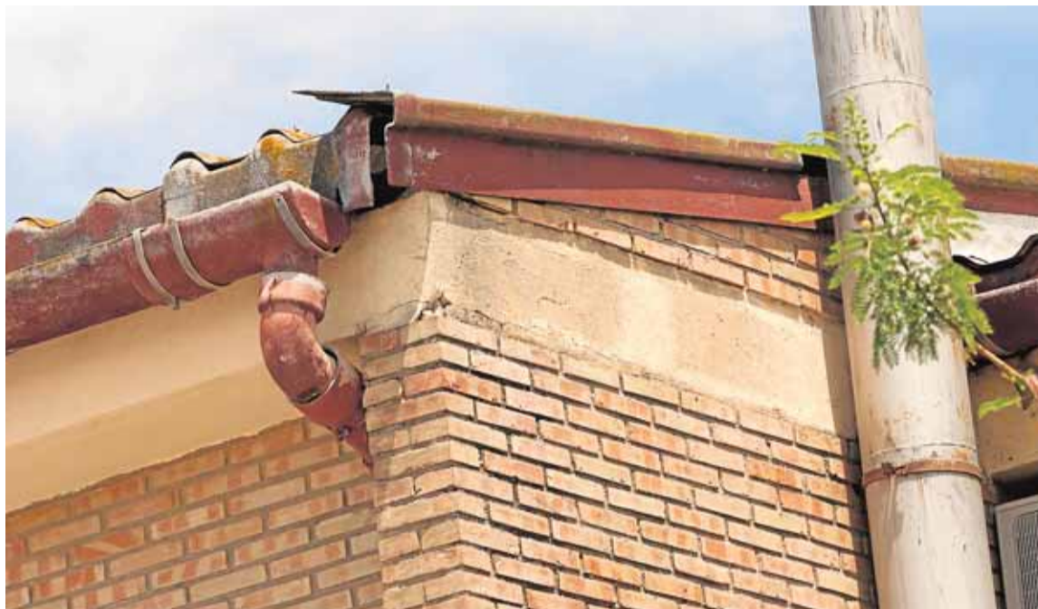
Parte de la cubierta del colegio José Calderón de Campanillas, visiblemente deteriorada. :: ÁLVARO CABRERA
