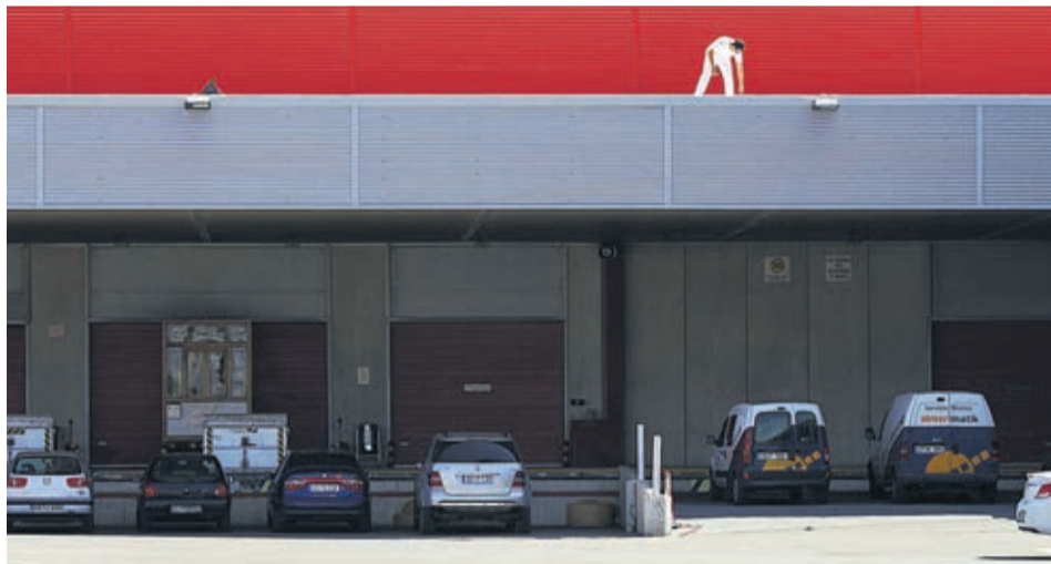
INSTALACIONES de CASI Aeropuerto donde se confeccionan los envíos de tomate rosa.
