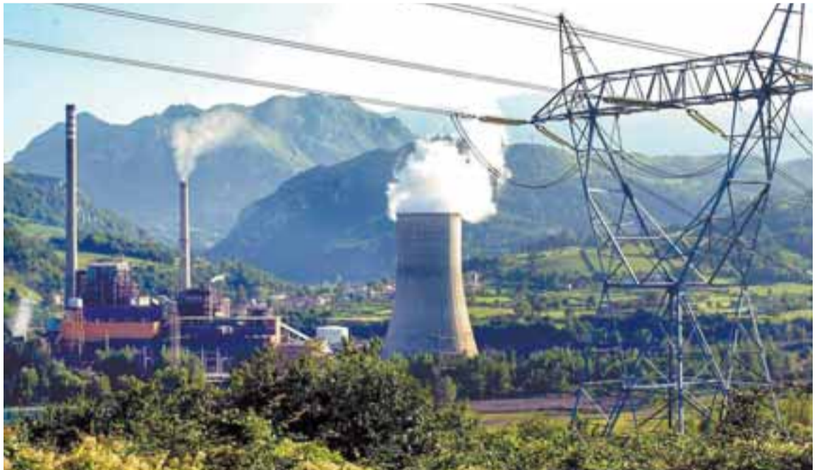
Panorámica de la central térmica de la localidad de Soto de Ribera, en Asturias. EFE
