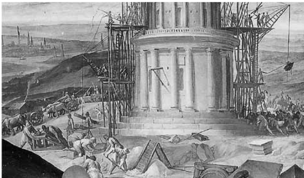
Detalle de los frescos de la Biblioteca del Monasterio de El Escorial, del panel dedicado a la construcción de la Torre de Babel, de Pellegrino Tibaldi y sus colaboradores. Se aprecia el trabajo con la cal, el transporte en carros de bueyes y las grúas e ingenios constructivos.
