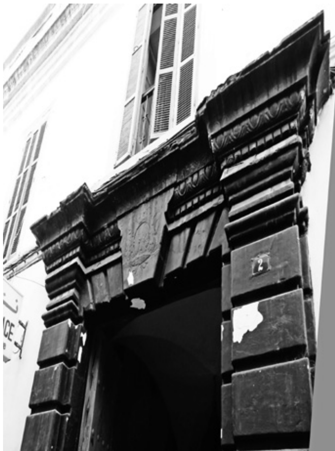
8. Portada manierista del edificio, estado actual
