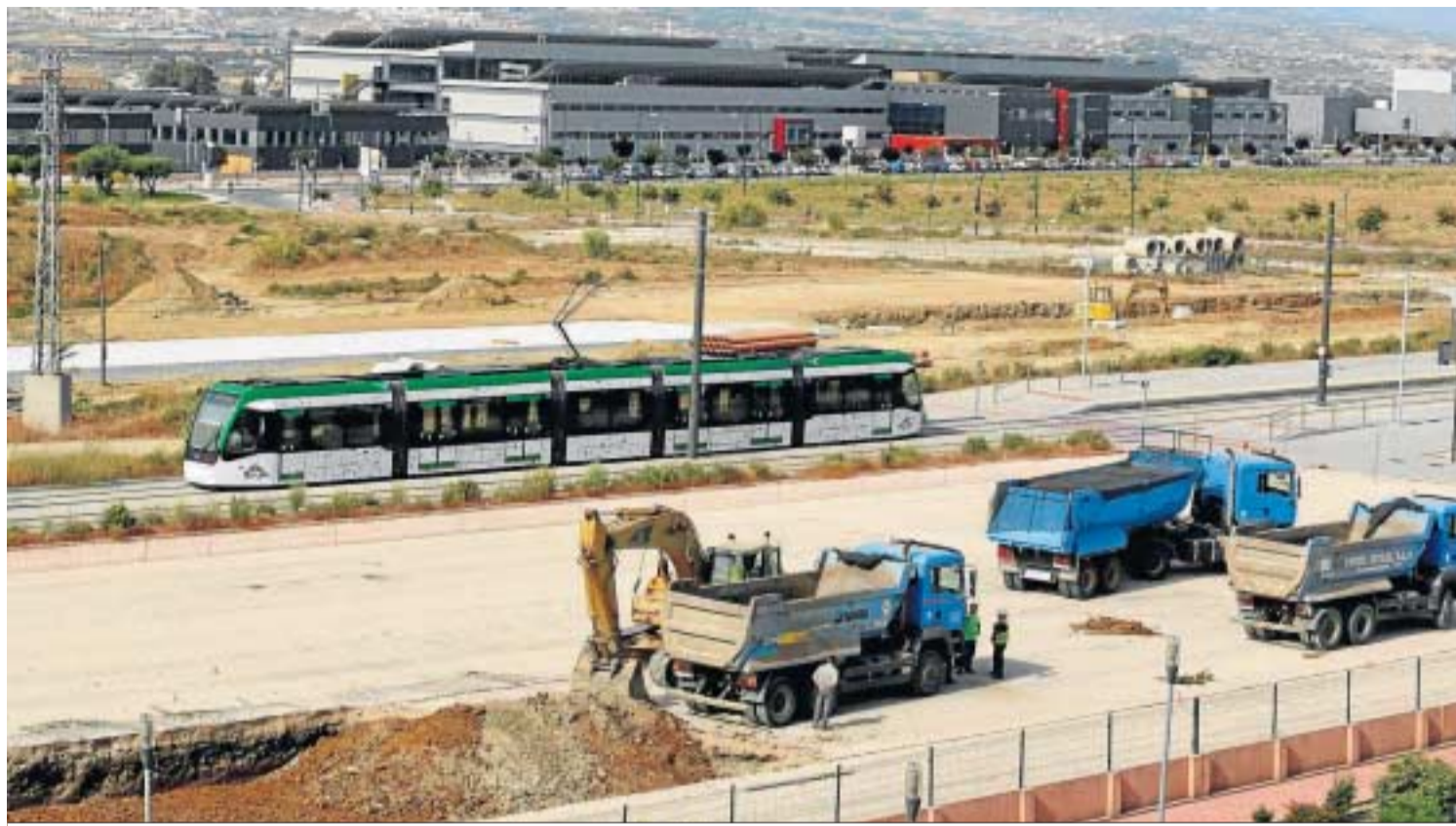
El Metro pasa junto a las máquinas que trabajan en la prolongación del bulevar Louis Pasteur hacia la ampliación de la Universidad.
