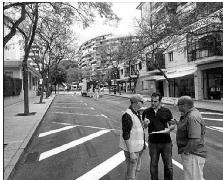
Técnicos y responsables municipales, en las obras. LA OPINIÓN
