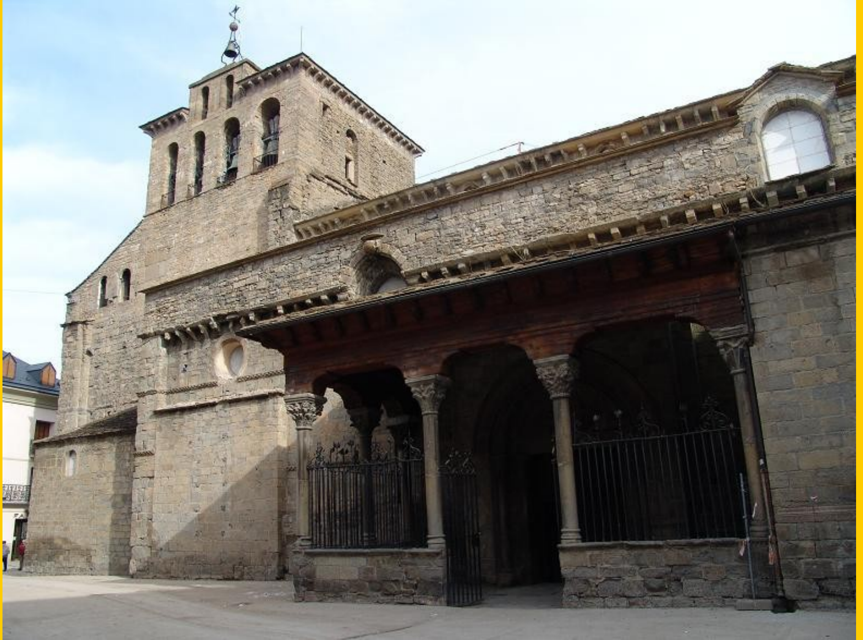
Pórtico sur o Lonja chica. Protege la fachada sur
