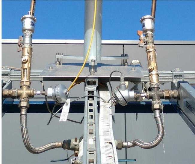
**Figura 3.5.** Visores de líquido, sondas, purgadores y llaves de corte conectados a crucetas de  $\frac{3}{4}$ "
