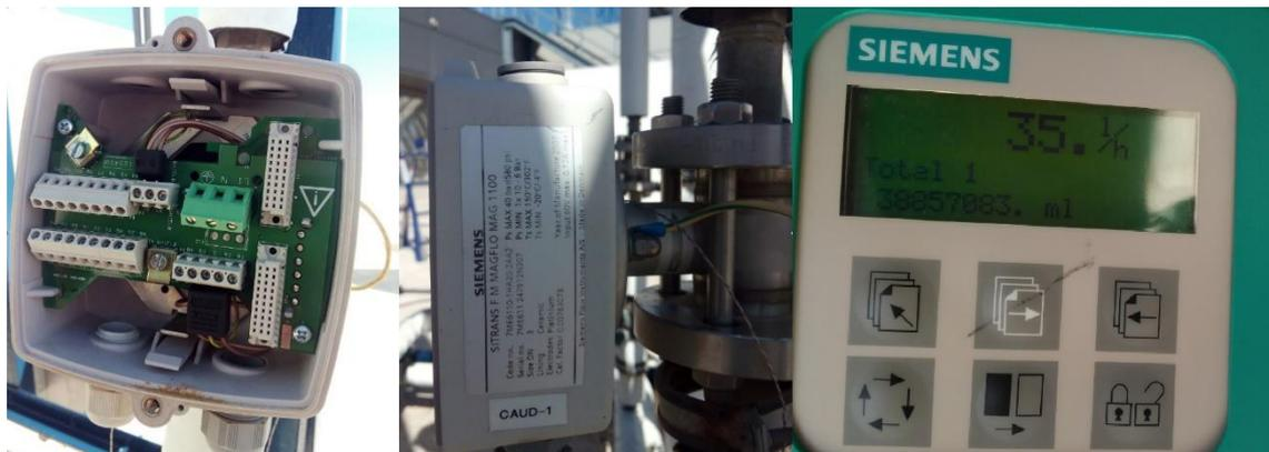
Figura 3.10. Regleta de conexiones, paso calibrado y cabezal de los caudalímetros instalados
