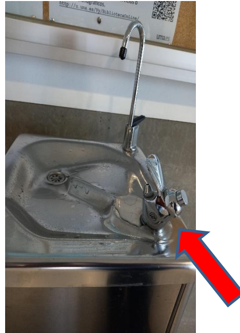
Ilustración 2. Señalado el mecanismo de flujo de agua que se debe anular.
