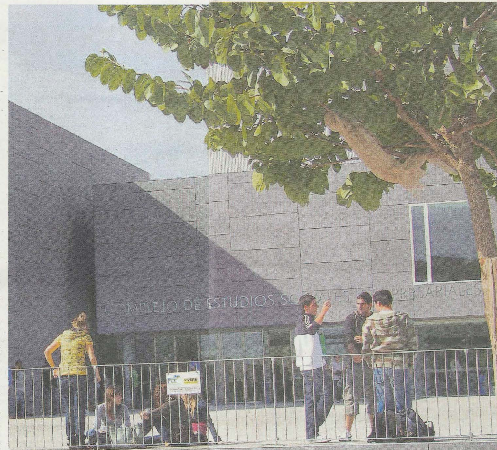
Entrada de la Facultad de Comercio y Gestión, situada en los terrenos de ampliación del campus de Teatinos. s.e.c.
