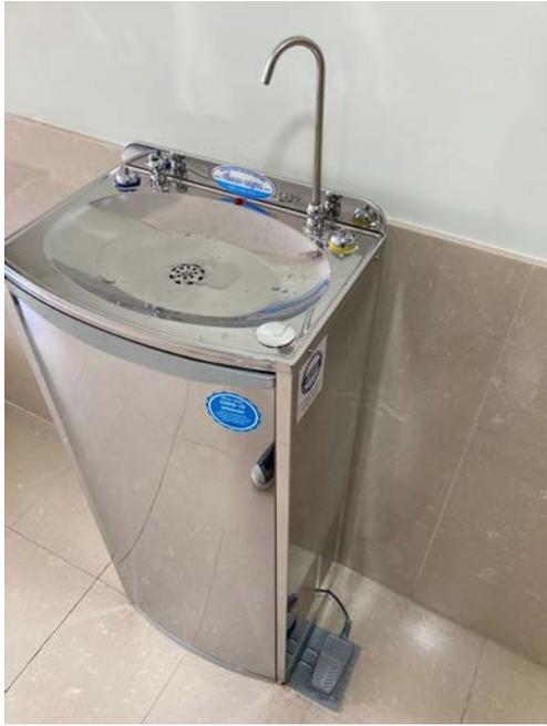
**Ilustración 6.** Fuente de agua alimentada por agua de red, con pedal de pie
