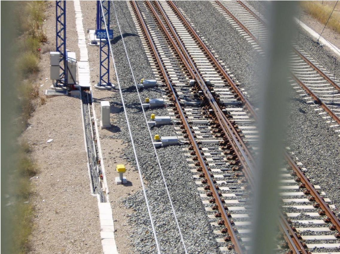
**Fotografía 3.** Desvío en la red de alta velocidad de Adif Alta Velocidad (zona del corazón de punta móvil). Fuente: Adif.
