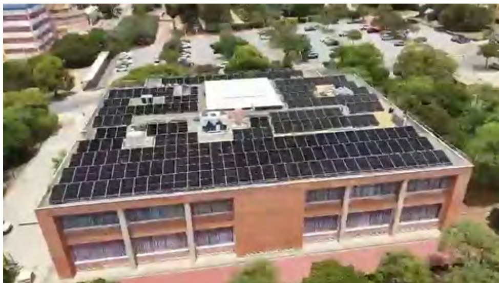
Imagen aérea instalación fotovoltaica en el aulario Severo Ochoa
