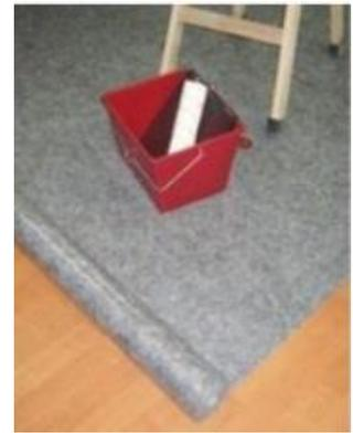
Además, todo el mobiliario y demás elementos susceptibles de cubrirse de polvo o mancharse se cubrirán con plásticos, con los que estarán completamente protegidos. Igualmente, quedarán totalmente protegidos (mediante plásticos, papel para obras y pintura, etc.) los elementos verticales (paredes, luminarias, lucernarios, ventanas, cristales, puertas, etc.) y horizontales (suelos) de toda la zona donde se esté realizando la reforma u obra.
