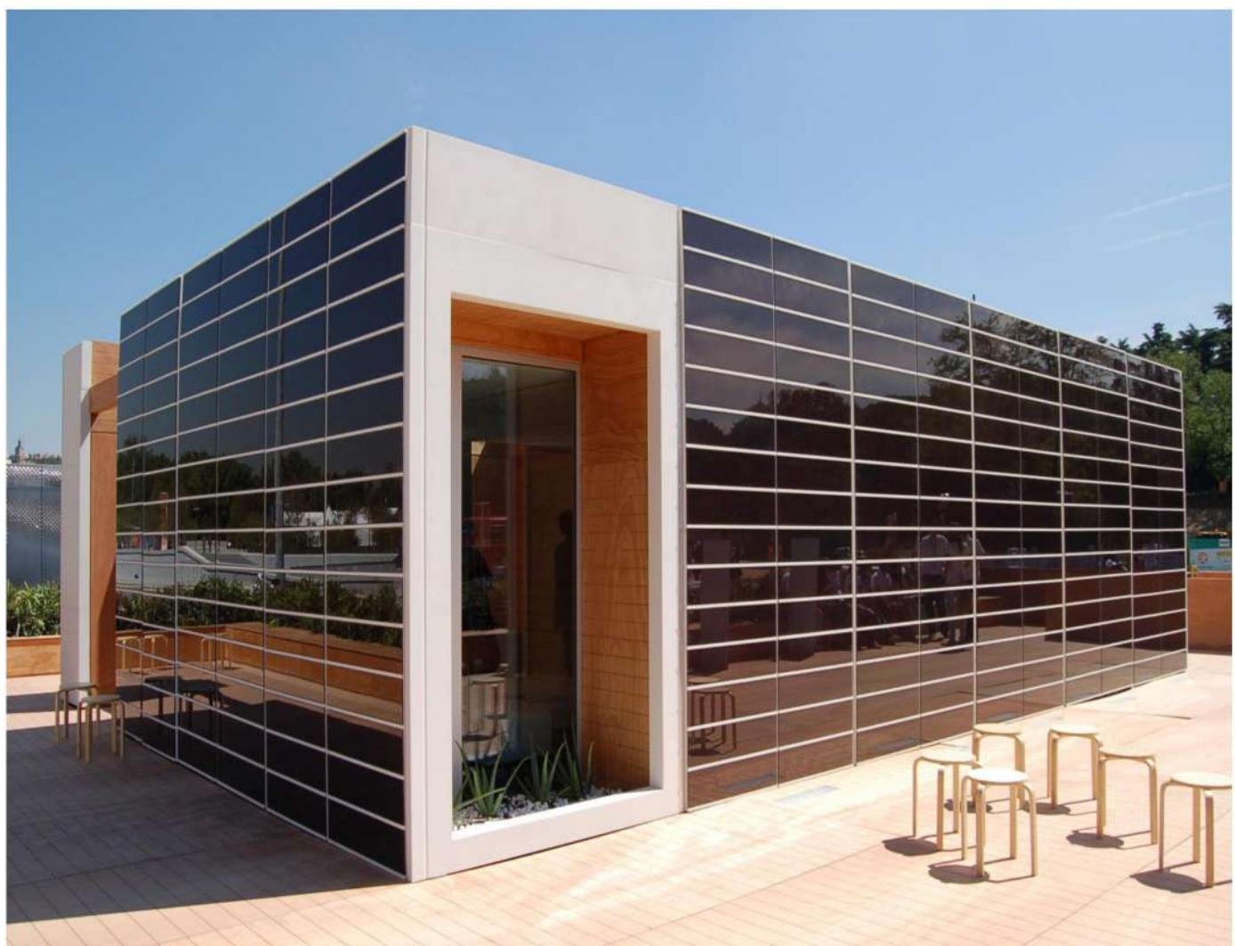
Fig 1. Ejemplo de casa diseñada empleando BIPV. Tomada de: <https://onyxgreenbuilding.wordpress.com/tag/ceu-university/>
