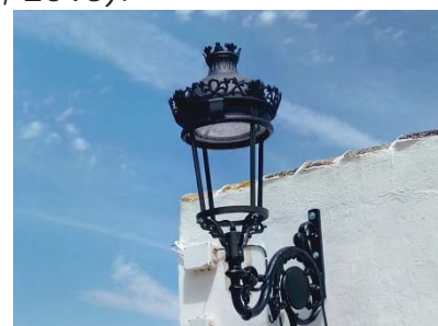
Figura 2.20. Luminaria clásica tipo Fernandina sobre brazo de fundición de aluminio en Serrato. Fuente: Elaboración propia.
