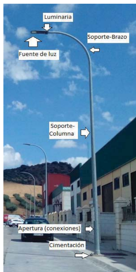
Figura 2.12. Elementos que conforman un punto de luz. Fuente: Elaboración propia.
