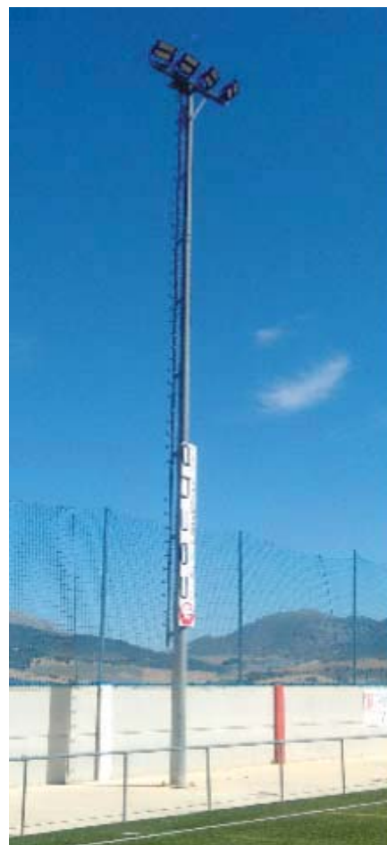
Figura 2.21. Torre de proyectores LED en el Campo de Fútbol de Casabermeja. Fuente: Elaboración propia.
