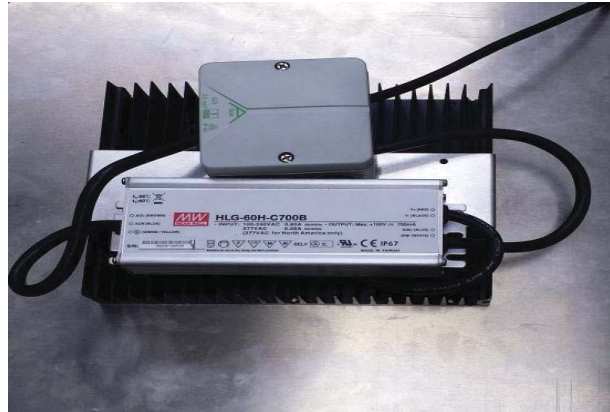
Figura 2.16. Driver adosado al disipador y elemento de protección contra sobretensiones. Fuente: Elaboración propia.
