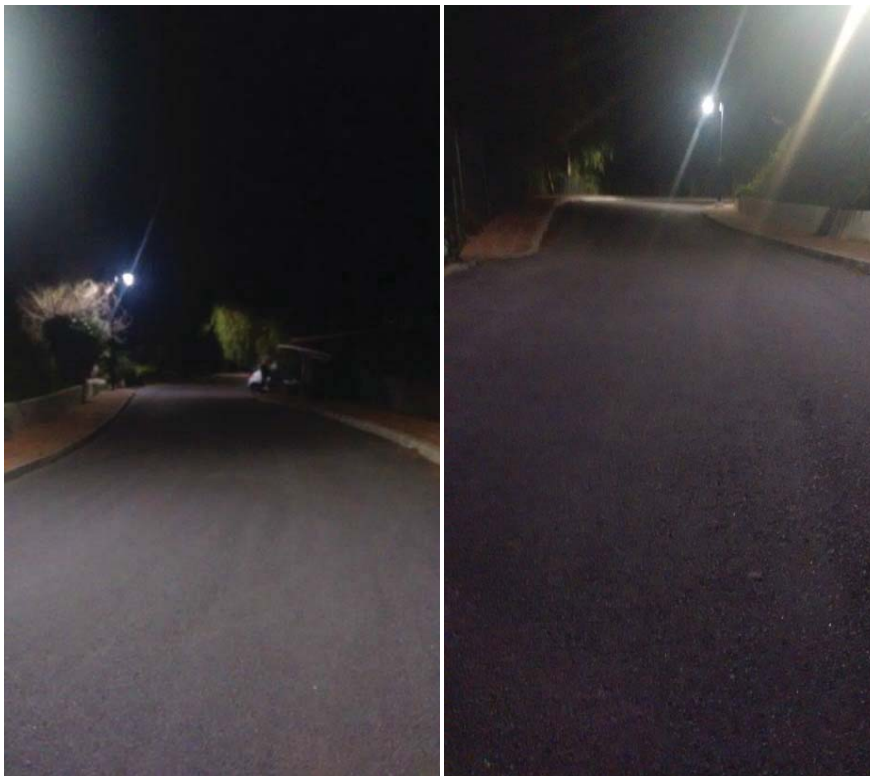
Calle la Estación
