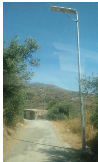
Figura 2.14. Luminaria viaria solar en Cútar. Fuente: Elaboración propia.
