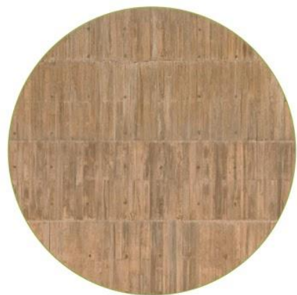
Hormigón en muros con textura de encofrado de madera vertical
